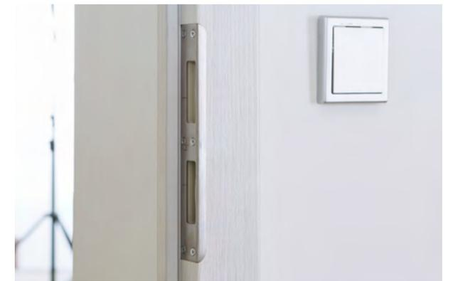
verstärktes Schließblech mit rückseitiger Metallplatte
